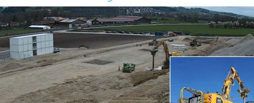
Aktuell erfolgt die Bodenstabilisierung mittels Rüttelstopfsäulen der unterkellerten Bereiche der Werkstätten Die Stabilisierung im Bereich des ersten Kranstellplatzes ist abgeschlossen
