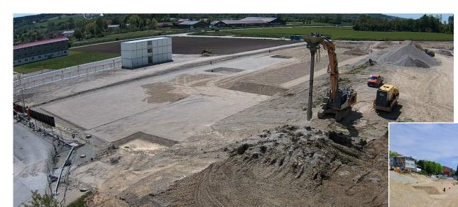
Die Betonarbeiten im Baufeld des Logistikgebäudes sind abgeschlossen. Derzeit werden die Abdicht- und Dämmarbeiten ausgeführt. Die Schal- und Betonarbeiten im Bereich des Kopfbalken der westlichen Bohrpfahlwand sind in vollem Gange.
